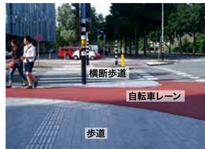
写真⑤ 自転車レーン(赤)と歩行者帯(灰色)が明確に分離されているアムステルダムの交差点。
