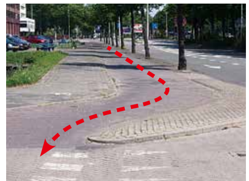
写真⑨ 交差点手前で大きくカーブしている自転車レーン。これにより自動車の巻き込み事故を防止する。
