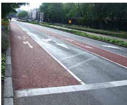
写真⑥ 左から直進・右折自転車、直進・右折自動車、左折自転車、左折自動車の4つのレーンに分離。
