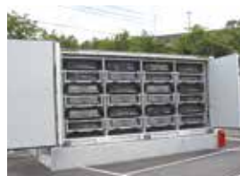
写真⑥ 新型リユースバッテリーコンテナとコンテナ内に収納されているバッテリー
