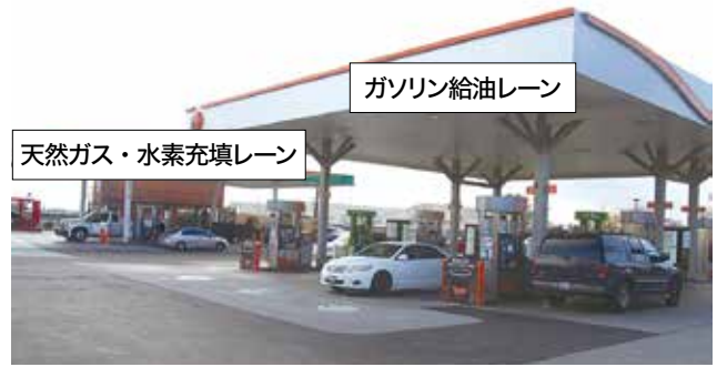
写真③ 水素充填機は天然ガス充填機のすぐ隣にあり、水素は天然ガス同様の扱い
