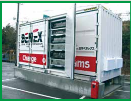
リユースバッテリーを格納してあるコンテナ
