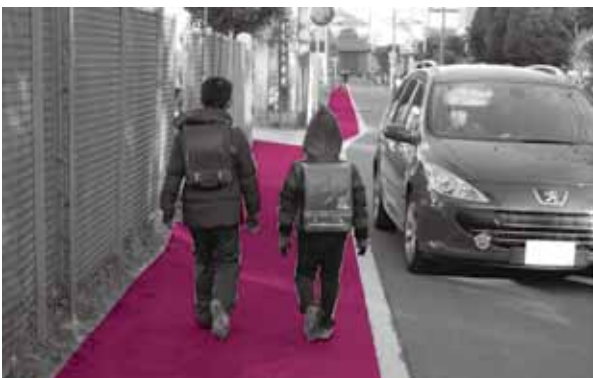
写真② 薬円台小学校の東側の校門前の道路は、学校側の路側帯をグリーンにカラー舗装(写真では赤く表示)して歩行空間を明確化
